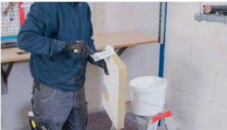
Beschichtungsmasse aufrühren und Kabel im Schottbereich mit BML, sowie die Laibungen und Kanten der Mineralfaserplatten mit BML oder BMS/BMK einstreichen. Platten ein- oder zweilagig in die Öffnung einbringen.
